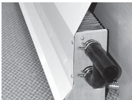
Fig. 90 : Convecteur avec plaque chauffante
