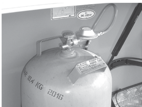
Fig. 75 : Vanne de détendeur
