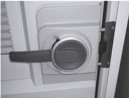
Fig. 13: Serrure de porte fermée mais non sécurisée
