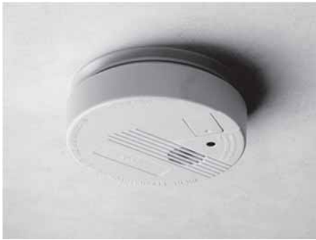
Fig. 37: Détecteur de fumée
