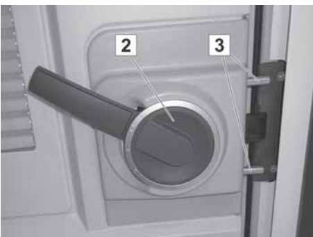
Abb. 15: Tür geschlossen und gesichert
