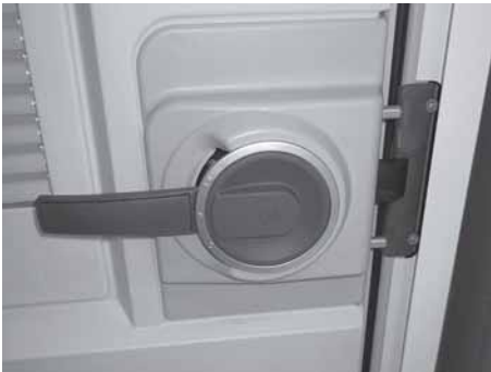
Abb. 13: Türschloss geschlossen, aber ungesichert
