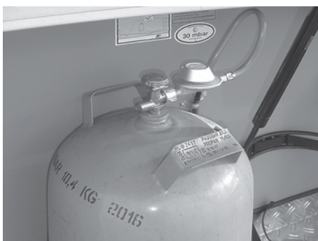
Abb. 112: Gasflasche mit Druckminderventil
