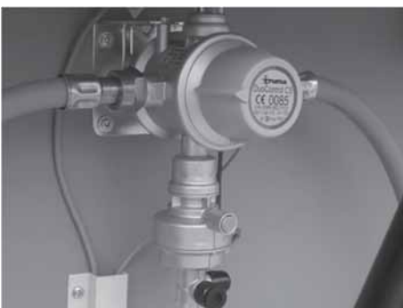
Abb. 114: Gasversorgung DuoControl CS
