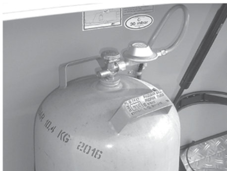
Abb. 75: Druckminderventil
