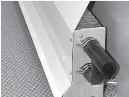
Abb. 88: Konvektor mit Wärmeleitblech
