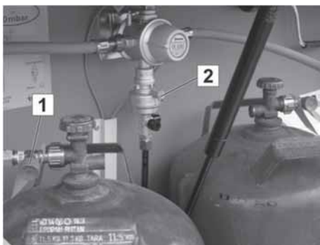
Abb. 116: Gasdruckregler
