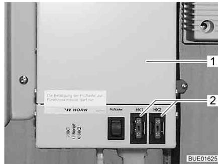
Fig. 125 Regolatore riscaldamento per tubazioni delle acque grigie
