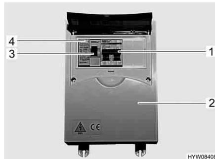
Fig. 48 Coffret de fusibles 230 V avec disjoncteur de protection de circuit et disjoncteur FI
