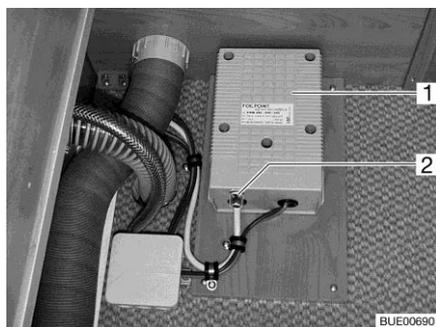
Fig. 120 Transformateur du chauffage électrique du plancher
