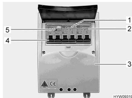
Fig. 100 Disjoncteur de protection de circuit et disjoncteur FI (coffret de fusibles 230 V)
