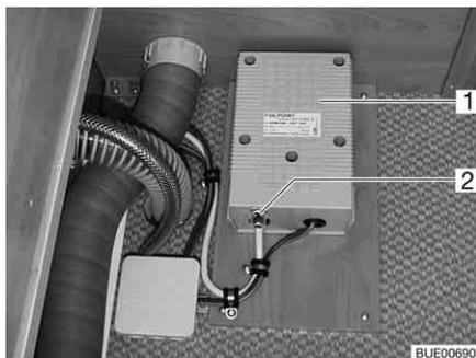
Fig. 144 Transformateur du chauffage électrique du plancher
