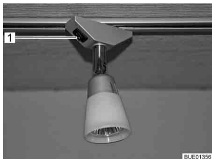
Billede 74 Spotlampe, lyskontakt direkte ved lampen
