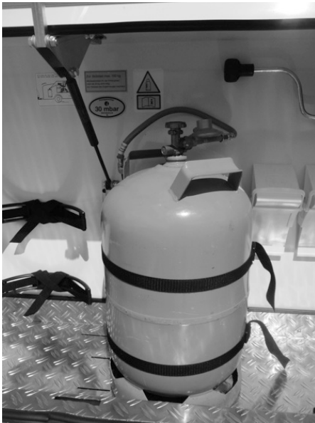
Fig. 77 : Vanne de détendeur
