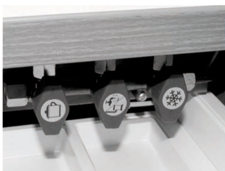
Fig. 81: Vannes d'arrêt rapides
