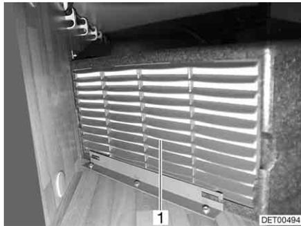
Fig. 206 Instalación de aire acondicionado (Truma)
