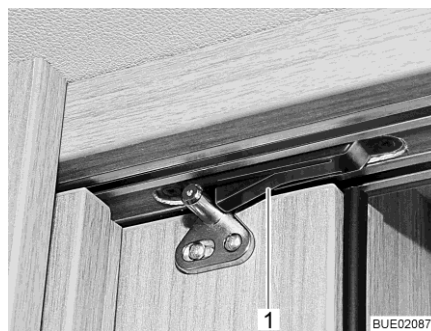
Bild 9 Raste mit Feder
