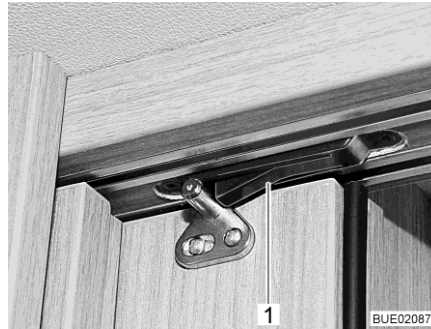
Bild 9 Spärr med fjäder
