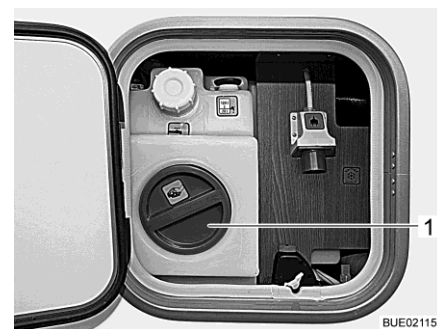
Bild 197 Rengöringsöppning på vattentanken (serviceenhet)
