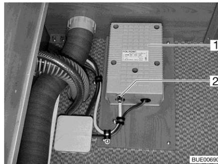
Fig. 168 Transformador para calentamiento eléctrico del piso
