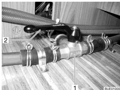
Fig. 161 Válvula de 3 vías
