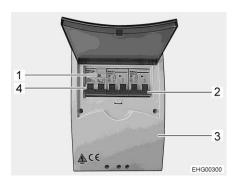
Fig. 187 230 V fuse box (variant)
