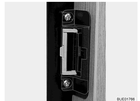
Billede 136 Låseanordning i udluftningsstilling
