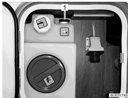
Fig. 273 Depósito de agua (unidad de servicio)
