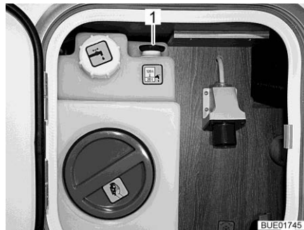
Fig. 273 Réservoir d'eau (unité de service)
