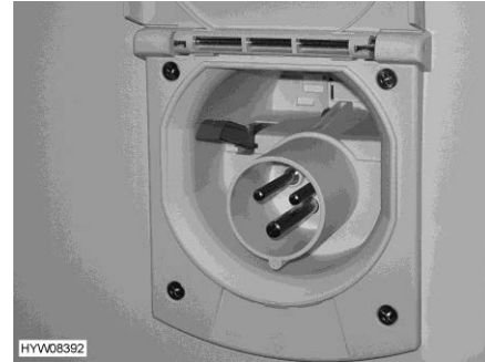
Bild 189 230 V-anslutning på fordonet (utan Service Unit)
