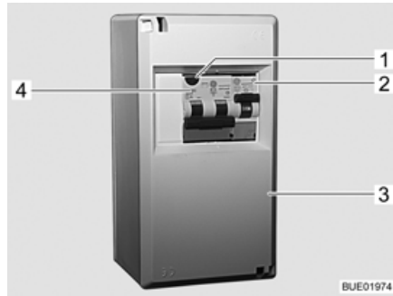
Billede 147 230 V-sikringskab
