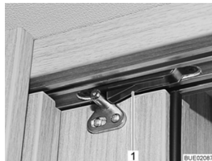
Bild 18 Spärr med fjäder
