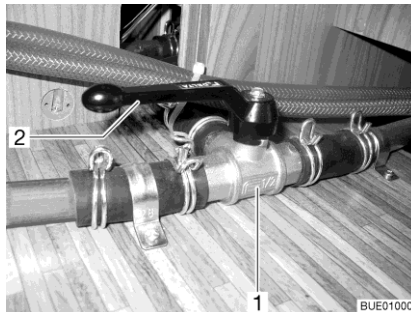
Fig. 213 Vanne à 3 voies
