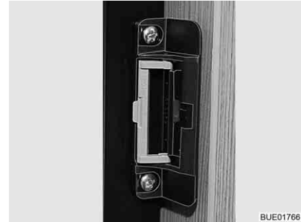
Kuva 205 Lukituslaitteisto tuuletusasennossa
