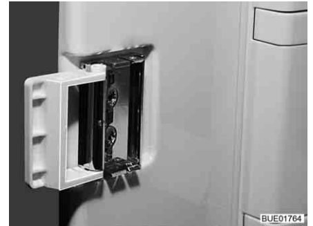
Bild 224 Verschlusseinrichtung in Lüftungsstellung
