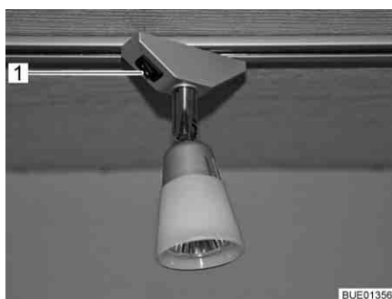
Afb. 58 Spotlight, lichtschakelaar direct bij de lamp (voorbeeld)
