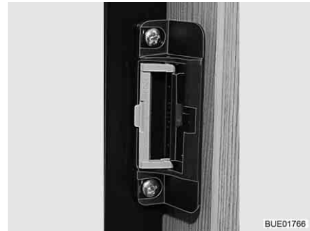
Kuva 226 Lukituslaitteisto tuuletusasennossa
