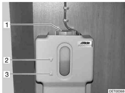
Fig. 258 Recipiente de compensación con panel
