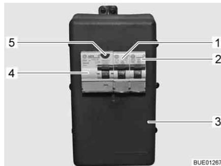
Fig. 142 Caja de fusibles de 230 V con interruptor de protección de línea e interruptor FI
