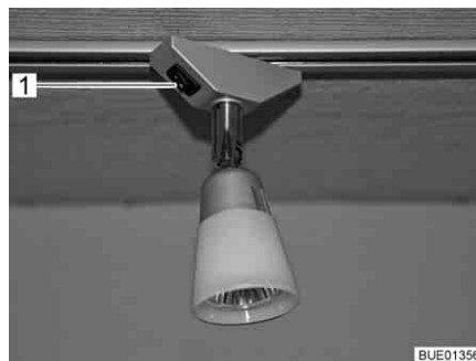
Billede 62 Halogenspotlampe, lyskontakt direkte ved lampen
