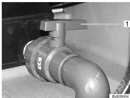
Bild 229 Avtappningskran
