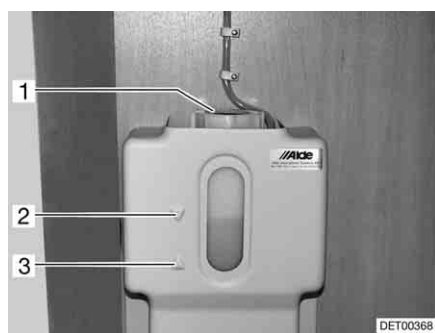
Fig. 263 Vaso d'espansione con diaframma
