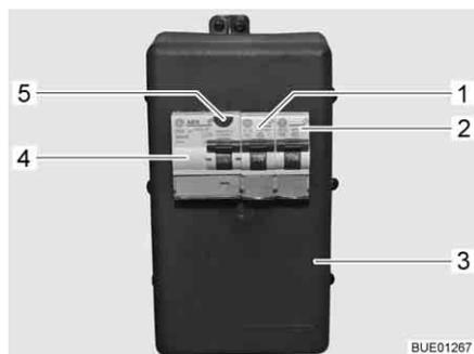
Fig. 139 Caixa de fusíveis de 230 V com disjuntor automático e disjuntor DR
