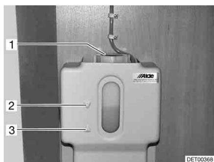
Fig. 235 Depósito de compensação do aquecimento de água
