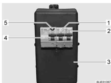
Fig. 96 Caja de fusibles de 230 V con interruptor de protección de línea e interruptor FI
