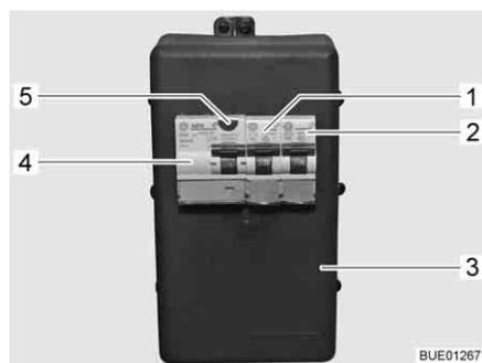
Fig. 89 Caja de fusibles de 230 V con interruptor de protección de línea e interruptor FI
