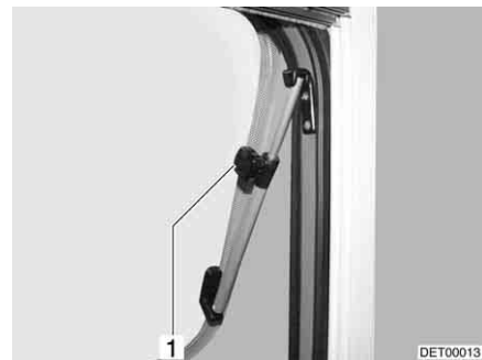
Bild 67 Överkantshängt fönster med vridspärrar, öppet
