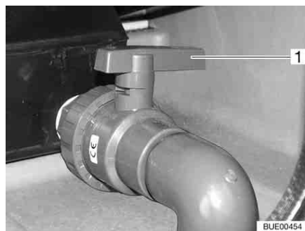
Bild 181 Avtappningskran (i dubbelgolvet)
