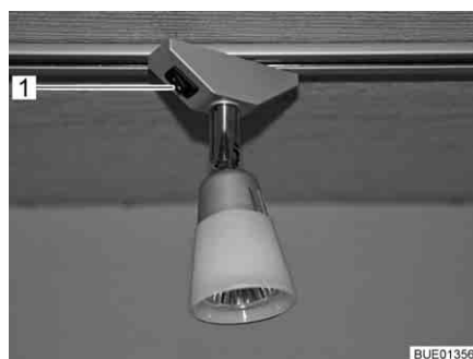
Kuva 53 Halogeenispottivalaisin, valokatkaisija suoraan valaisimessa
