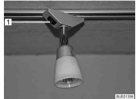
Bild 53 Halogenspotleuchte, Lichtschalter direkt an der Leuchte
