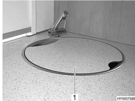
Fig. 11 Cubierta del fregadero
