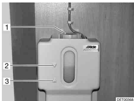
Billede 196 Udligningsbeholder varmtvandsvarmeovn
