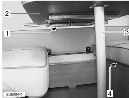
Bild 93 Ombyggnad till säng
