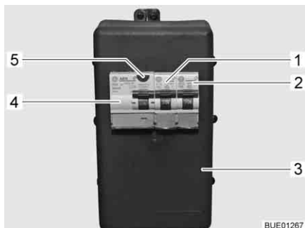
Fig. 152 Coffret de fusibles 230 V avec disjoncteur de protection de circuit et disjoncteur FI
