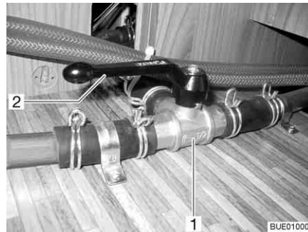
Fig. 168 Vanne à 3 voies
