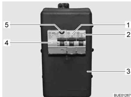
Fig. 152 Caja de fusibles de 230 V con interruptor de protección de línea e interruptor FI
