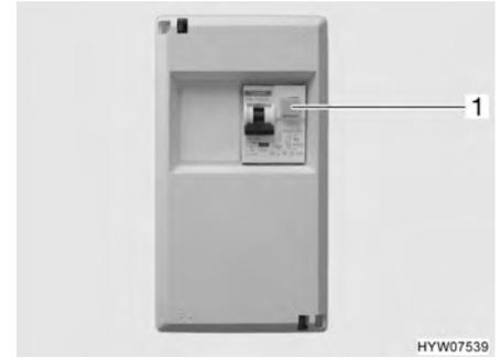
Fig. 117 Scatola dei fusibili a 230 V con interruttore di protezione della linea e interruttore di sicurezza per correnti di guasto (FI)
