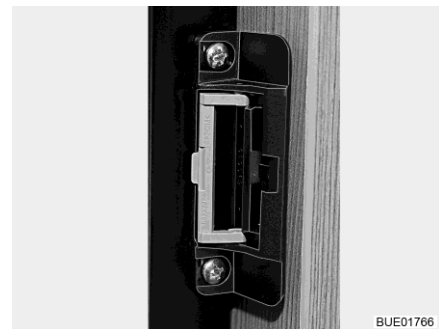
Bild 117 Verschlusseinrichtung in Lüftungsstellung
