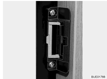
Fig. 90 Dispositivo de cierre en posición de ventilación
