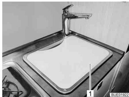
Fig. 2 Cubierta del fregadero
