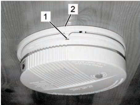
Fig. 112: Sett huset på plass
