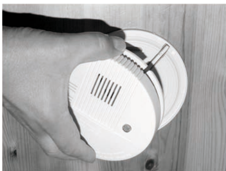
Fig. 110: Ta av huset
