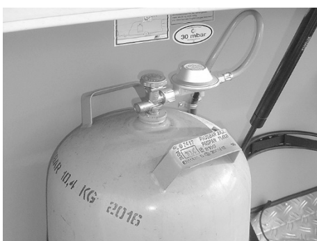
Fig. 103: Gassflaske med reduksjonsventil
