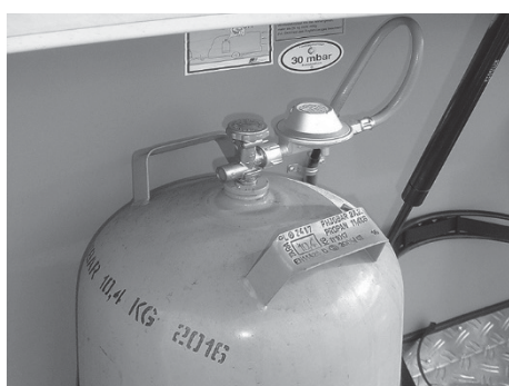
Fig. 114: Gassflaske med reduksjonsventil
