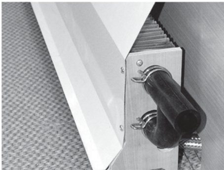
Fig. 90: Konvektor med varmeledende plate
