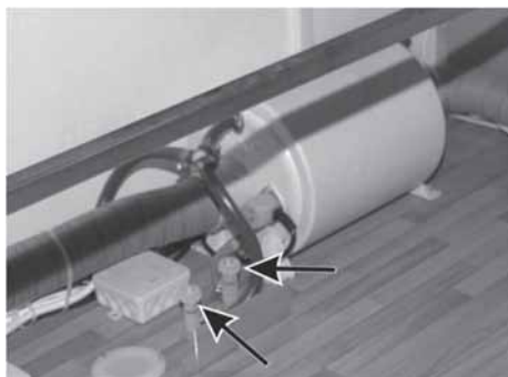
Fig. 99: TRUMA-varmeelement og vanntappeventiler
