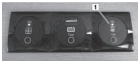
Afb. 79: Aan/uit-schakelaar van de vloerverwarming
