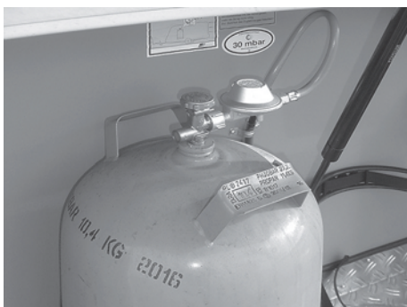
Fig. 92: Gasflaske med trykreduktionsventil
