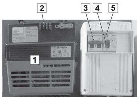
Fig. 55: Convertidor (equipo de red) (1) y fusibles automáticos
