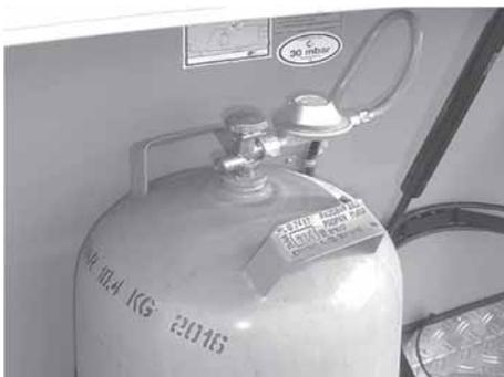
Fig. 69: Válvula reductora de presión
