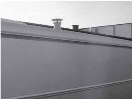
Fig. 74: Chimenea de gases de escape de la calefacción a gas
