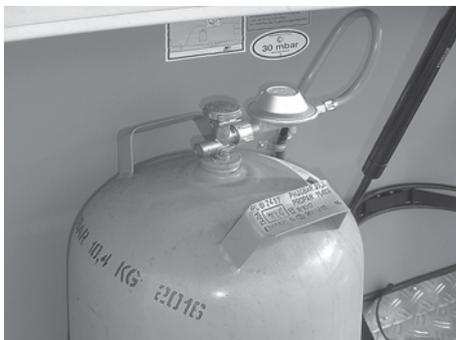
Fig. 92: Botella de gas con válvula reductora de presión
