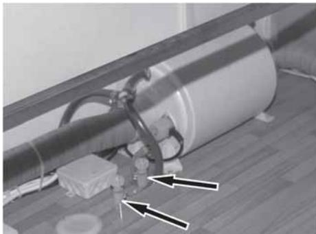
Fig. 113: Válvulas de descarga
