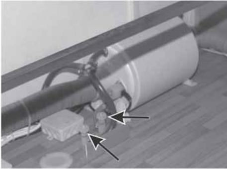
Fig. 82: Calentador y válvulas de descarga de agua TRUMA
