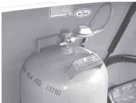
Fig. 69: Reduksjonsventil
